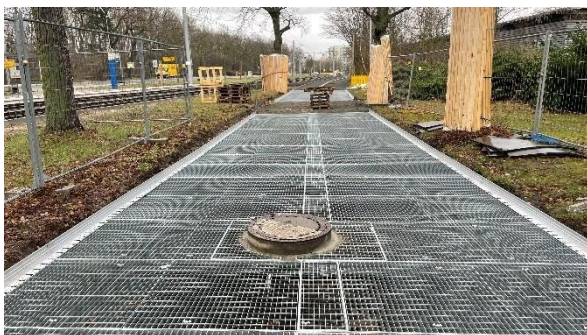
Abb. 5: Wurzelbrücke nach Einbau (Foto SVB Leitsch GmbH)
