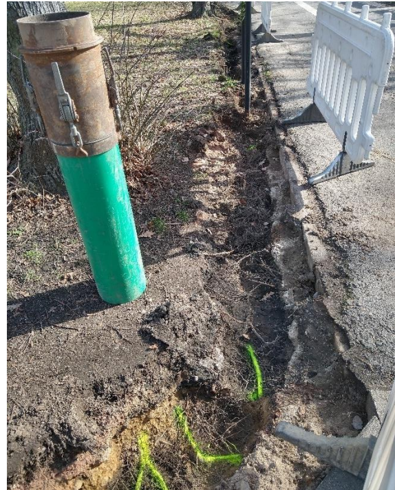
Abb. 4: Wurzelsuchgrabung (Foto SVB Leitsch GmbH)
