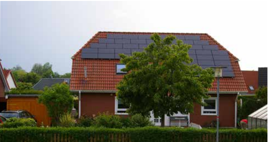
Abb. 7: Dieser Baum wird, wenn er ausgewachsen ist, die Photovoltaikanlage beschatten
