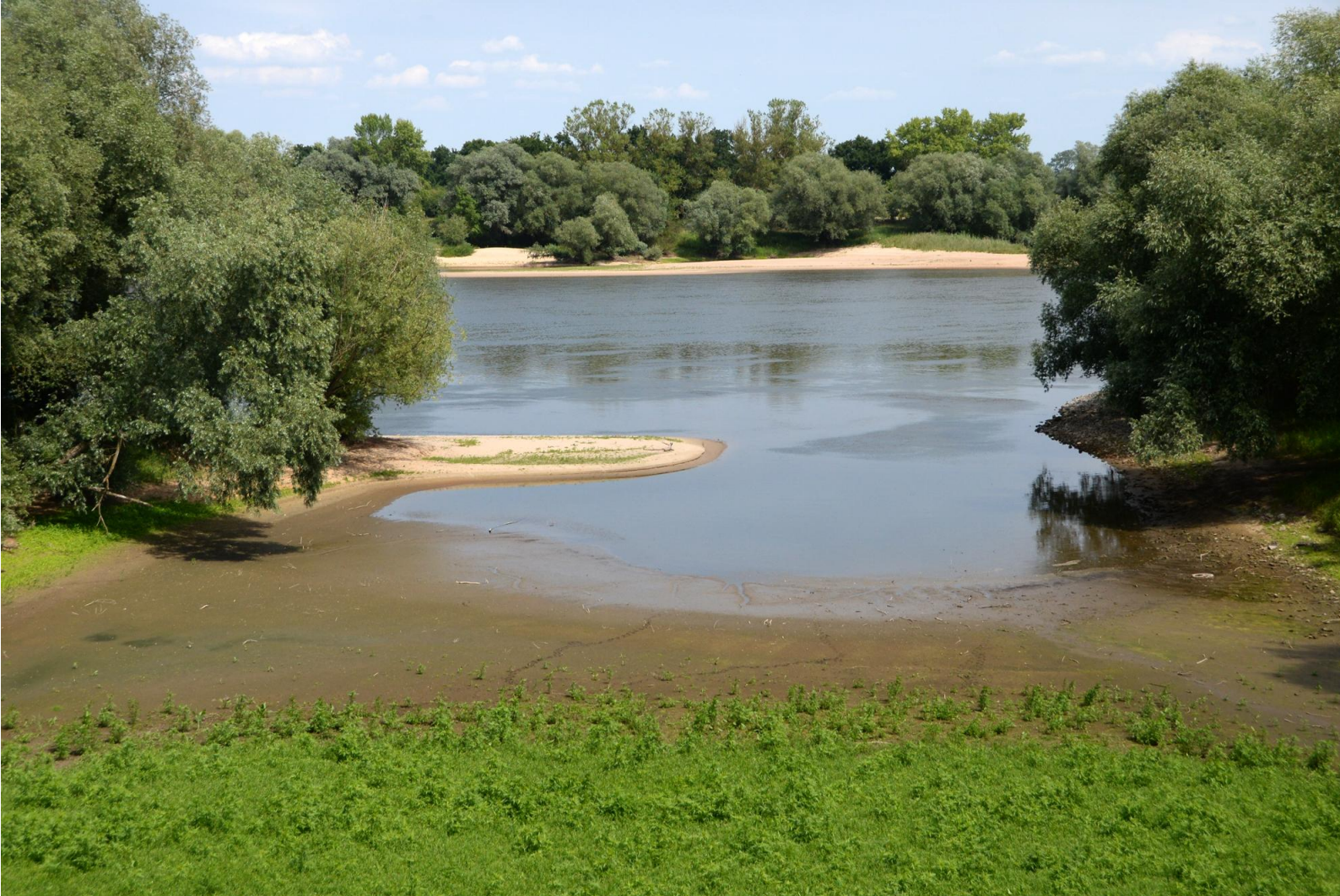
Bild 33: Ein Buhnenfeld zwischen zwei Buhnen (Buhnen sind Wälle oder Mauern, die in den Fluß gebaut werden, um das Wasser auf eine befahrbare Schafffahrtsrinne zu konzentrieren); Im Strömungsschatten der Buhne hat sich eine Sandzunge gebildet, klägliches Ersatz für den Lebensraum der wandernden Sandbänke und Inselufer
