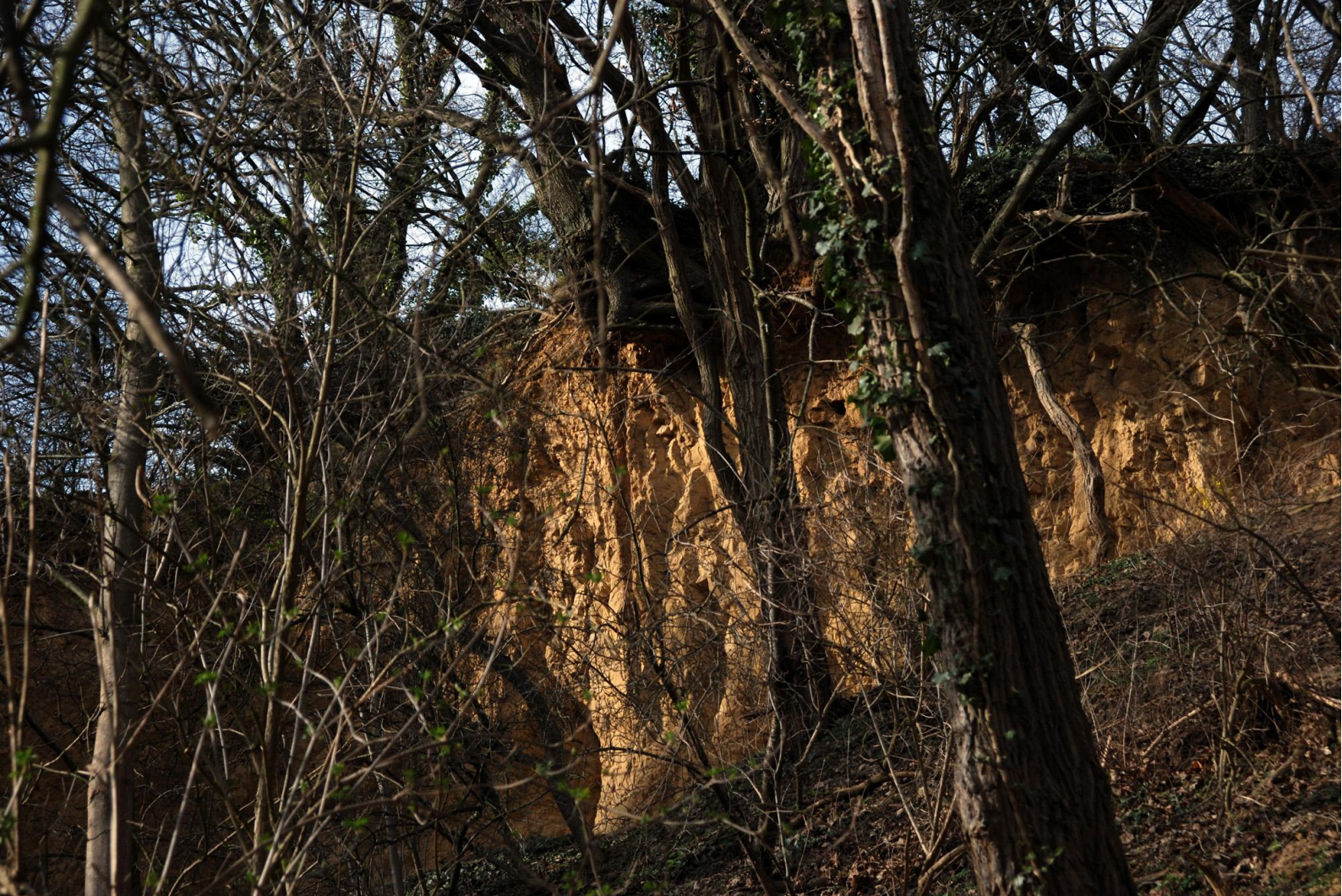
Bild 10: Frischer Hangabbruch am Steilhang bei Boizenburg-Vier
