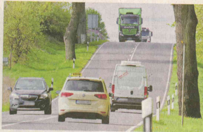
Die B96 zwischen Neubrandenburg und Neustrelitz weiter ausgebaut, einiges soll jetzt allerdings anders umgesetzt werden, als ursprünglich geplant. FOTO: B. WÜSTNECK/DPA
